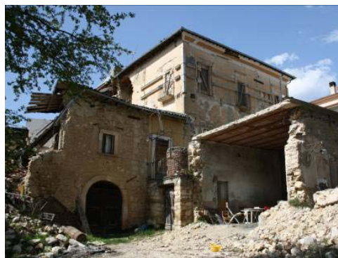
Figura 5_Palazzo De Matteis, veduta del retro del palazzo.
